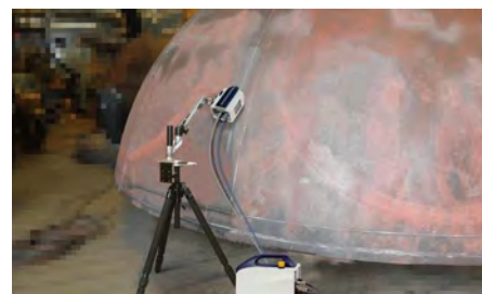
石油儲存槽: 焊接與退火效果的應力確認
